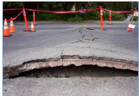
Abbildung 51: Blow-up in Folge von Hitze. Quelle: SDOT Photos / Flickr (2003).
