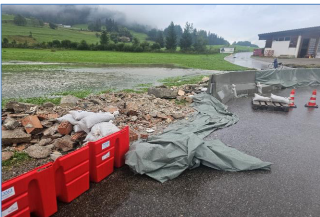
Abbildung 54: Dammbreach nach Sturm und Starkregen in Ofterschwang OT Westerhofen (Eigene Abbildung 2025).
