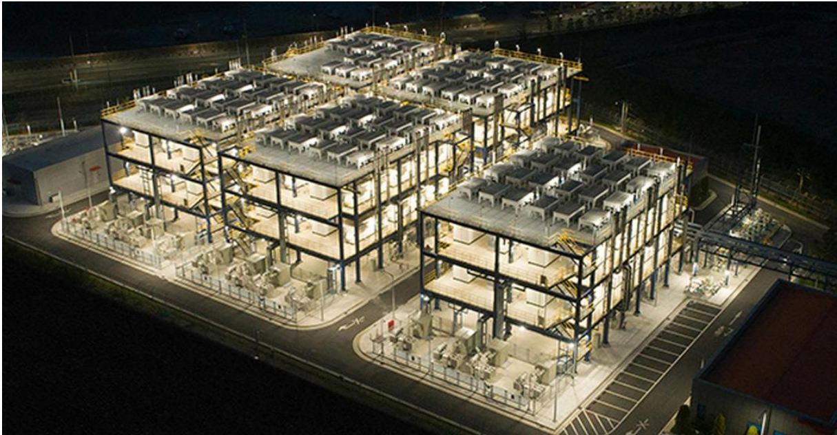
Abbildung 66: Brennstoffzellenkraftwerk in Seosan [76]
